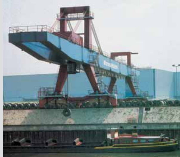
Blick auf den Portalkran View of the portal crane
